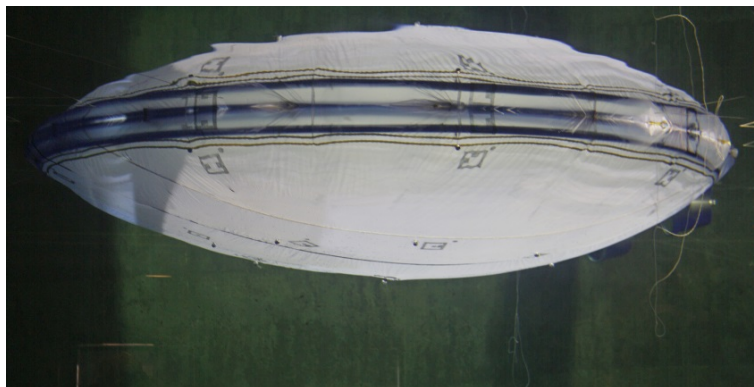
Figur 7: Muffinduk som er fylt etter setting, og ytterligere optimalisert fyllingsmessig ved at reduksjonsbeltet er løftet opp.
